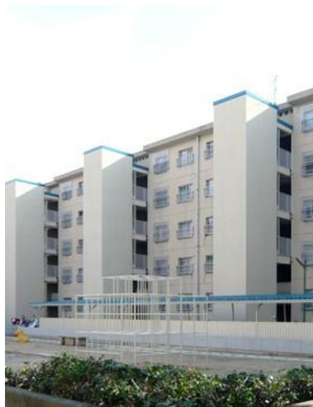
階段室型エレベーター
