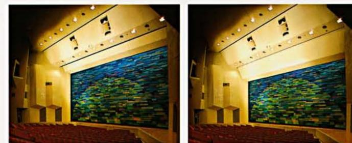
**プロセニウム可変機構**
