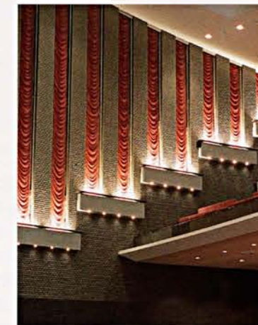
④客席の壁面、またはバルコニーに吸音幕を設けて開閉させる方式
