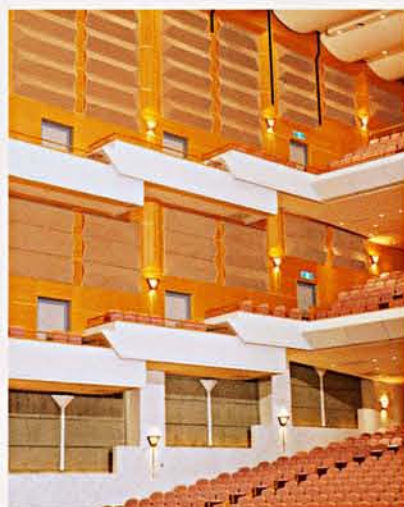
側壁面のパネルを反転し、吸音面を前面にしたパターンです。
